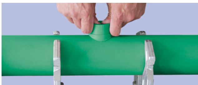
④ Нагриваното седло поставяме в нагривания отвор и фиксираме. След 1 ч. можем да запълним с вода и да повишим налягането.
