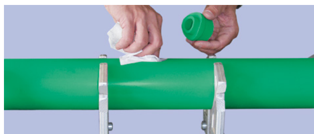
② Почистваме отвора и обезмасляваме фитинга и отвора.
